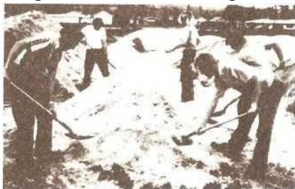
Стр.32. Предварительное перемешивание компонентов почвосмеси.
